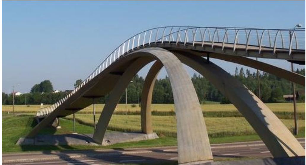
Fot.9. Kładka w As, niedaleko Oslo, Norwegia [22]
