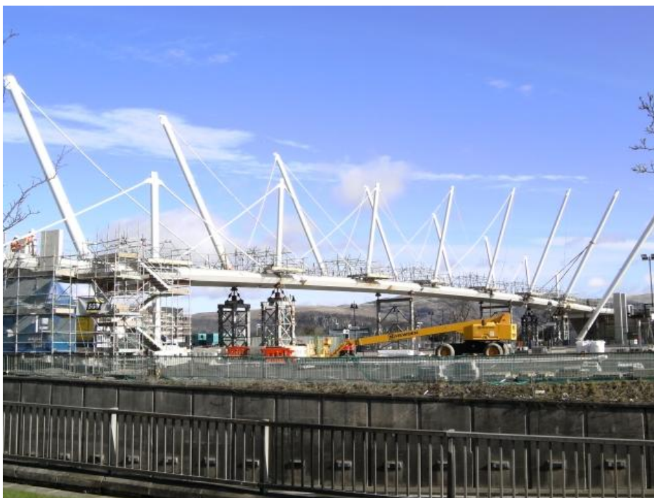
Fot.36. Forthside bridge podczas budowy [41]
