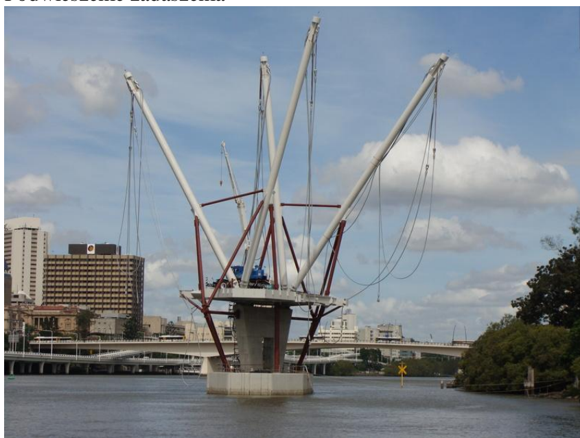
Fot.42. Główne maszty zamocowane do jednego z filarów [47]
