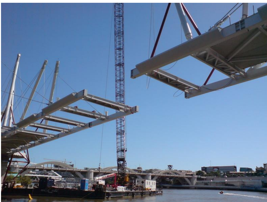
Fot.44. Północna i południowa część pomostu podczas montażu wspornikowego [49]
