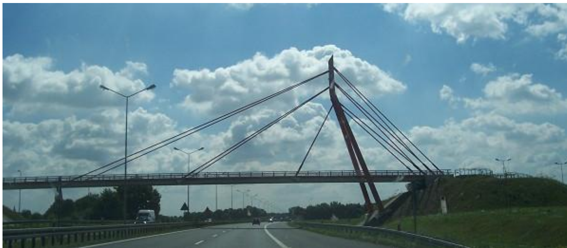
Fot.15. Kładka Krzywy Kij nad autostradą A4 [29]
