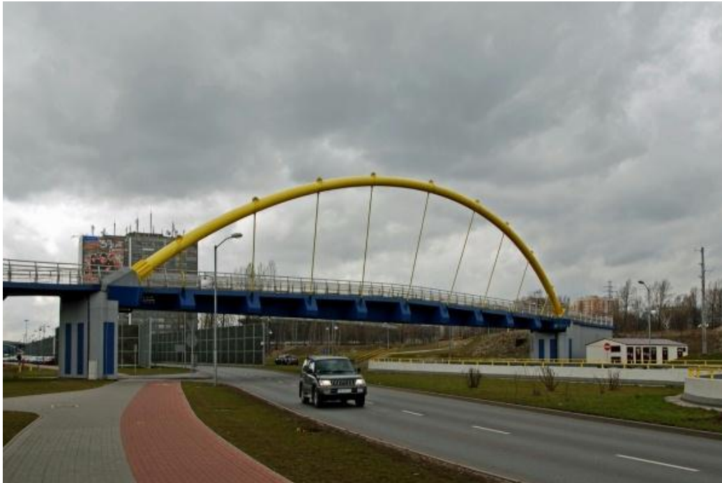
Fot.11. Kładka nad trasą DTS w Katowicach [24]
