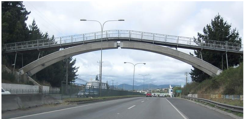
Fot.10. Trójprzegubowa łukowa kładka dla pieszych z pomostem opartym na łuku wykonanym z drewna klejonego znajdująca się w Chile [23]
