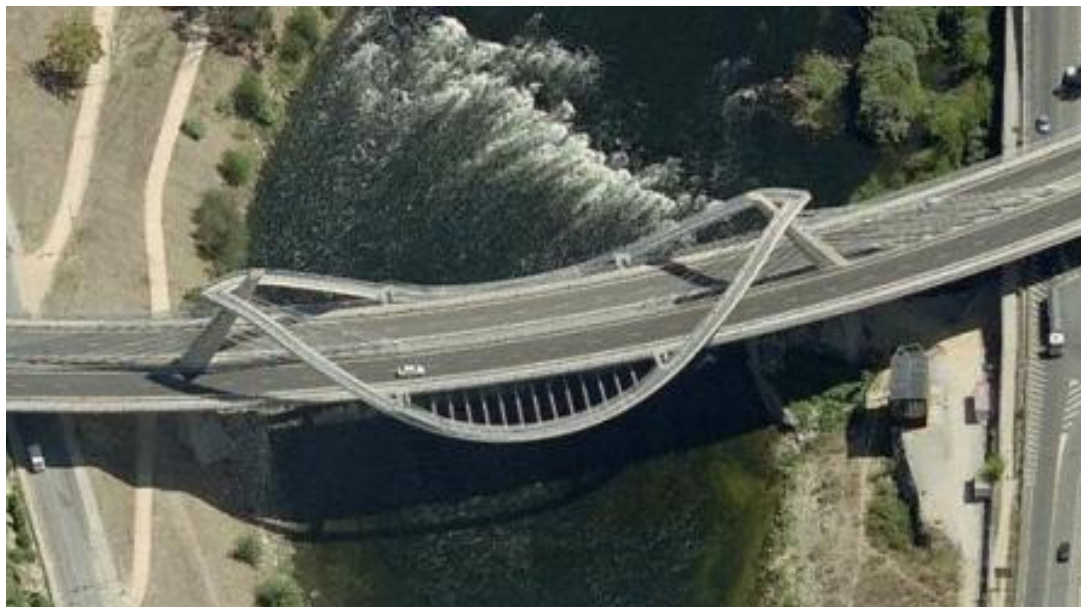
Fot.21. Kładka na moście Puente de Milenio , Hiszpania [34]
