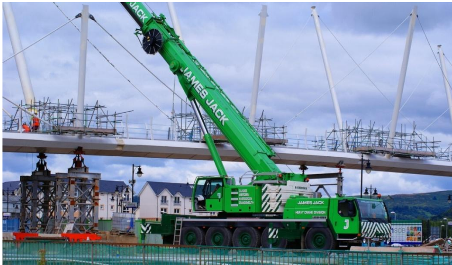
Fot.35. Forthside bridge podczas budowy [41]
