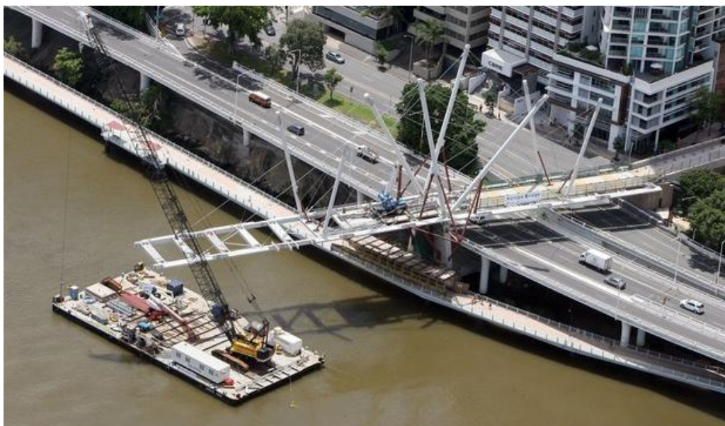
Fot.43. Część przęsła podczas montażu wspornikowego [48]
