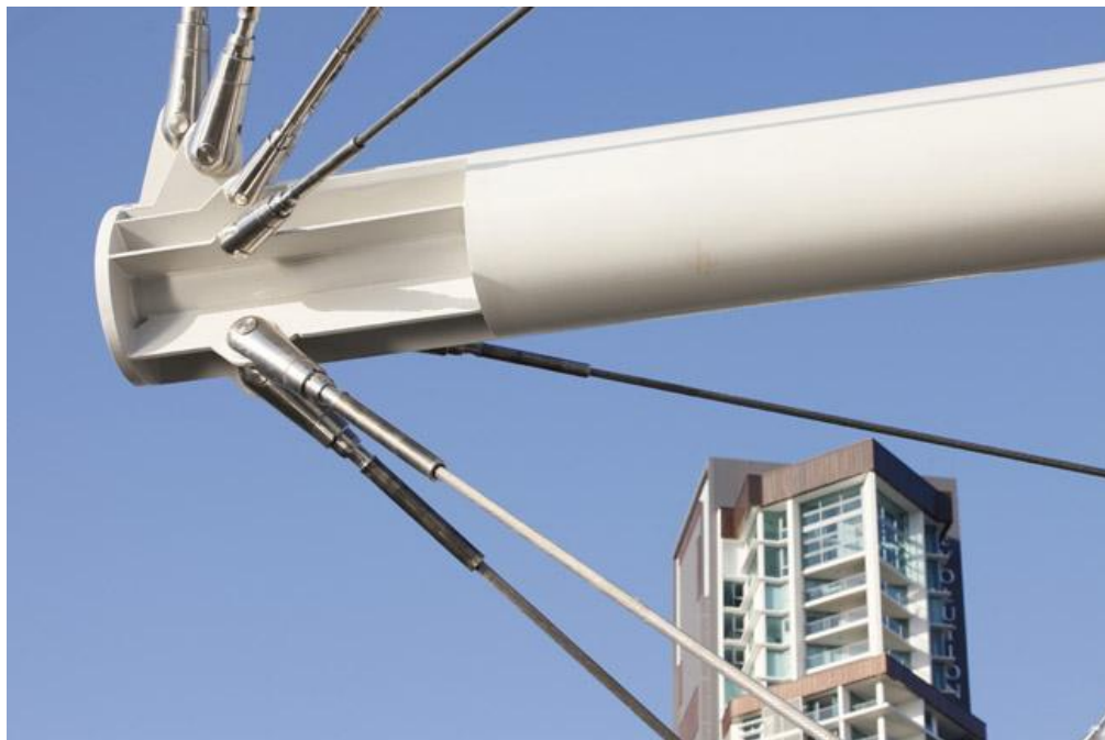
Fot.45. Połączenie cięgien z dźwigarem [50]
