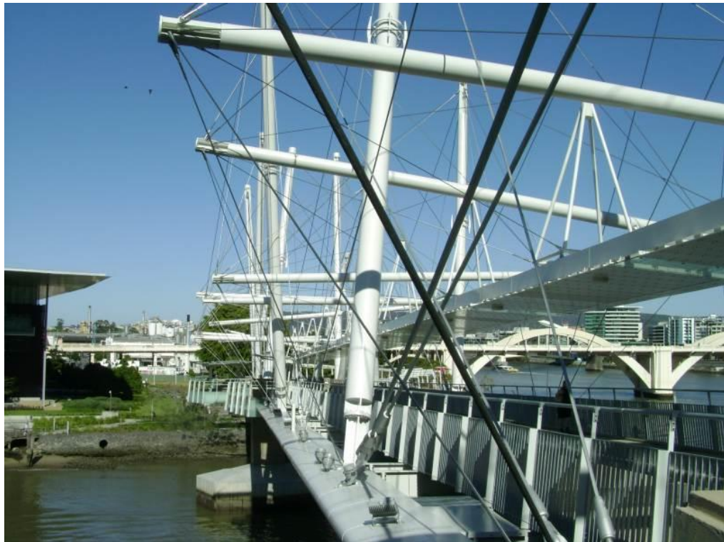
Fot.40. Poziome belki oraz kable drugorzędne podwieszające zadaszenie [46]
