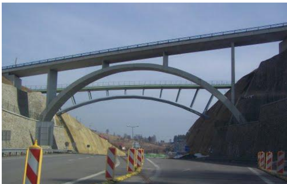
Fot.8. Wiadukt drogowy i kładka dla pieszych nad trasą S69 w Zwardoniu [21]
