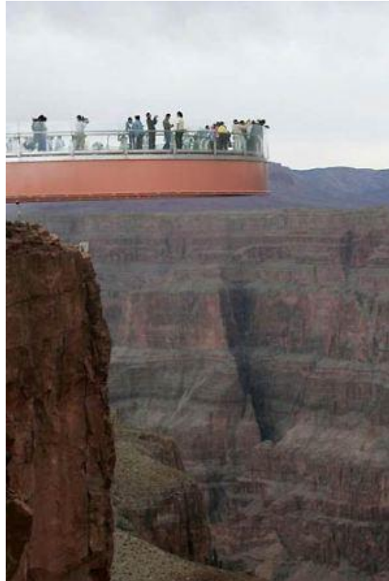
Fot.24. Kładka nad kanionem Kolorado, USA wersja zrealizowana [34]
