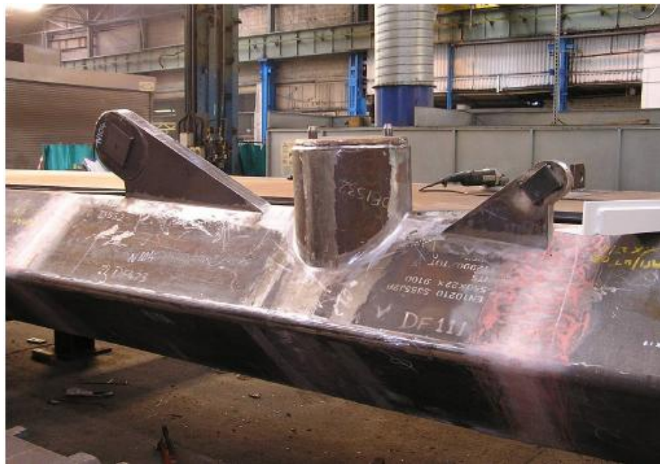
Fot.32. Belka pomostu w zakładzie prefabrykacji [2]
