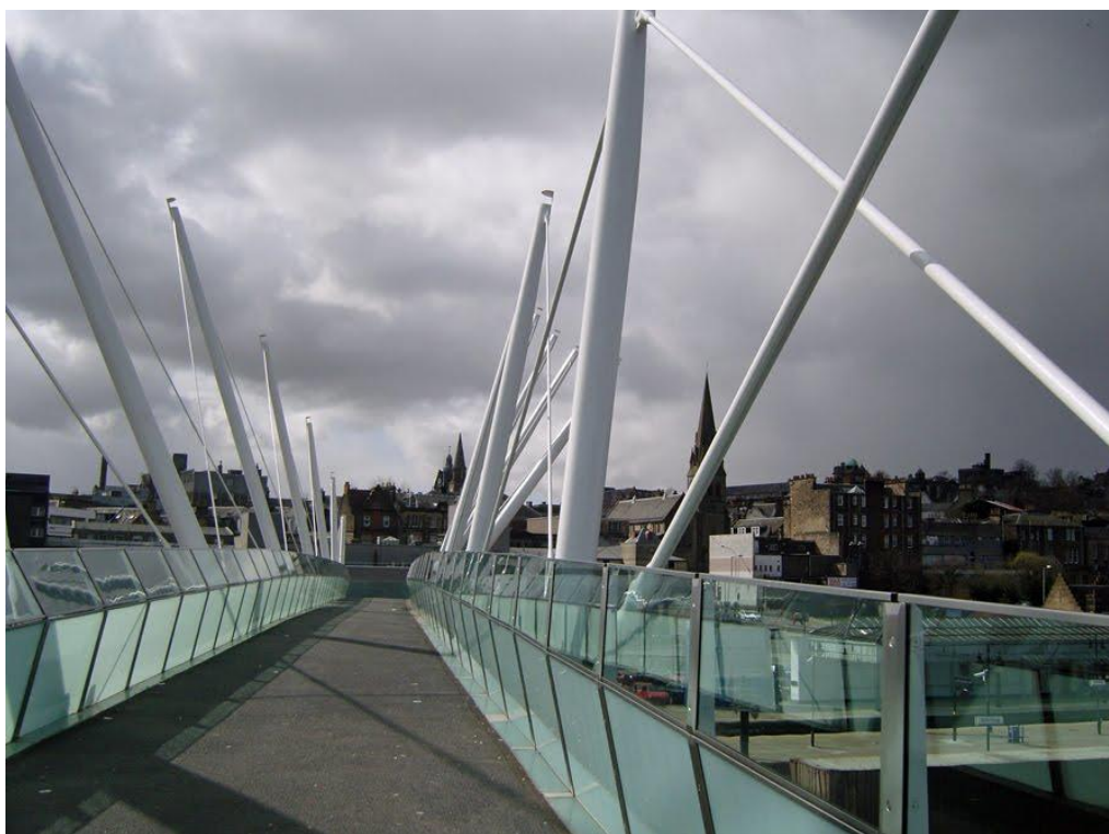
Fot.28. Forthside Bridge, widok z pomostu [37]
