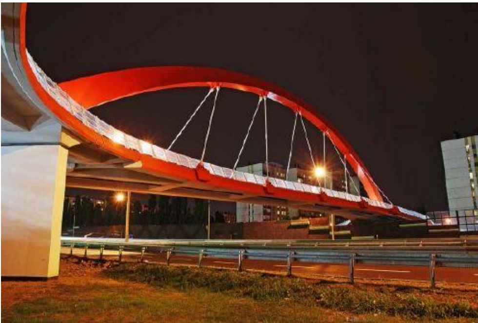
Fot.3. Kładka nad autostradą A4 w Katowicach [16]
