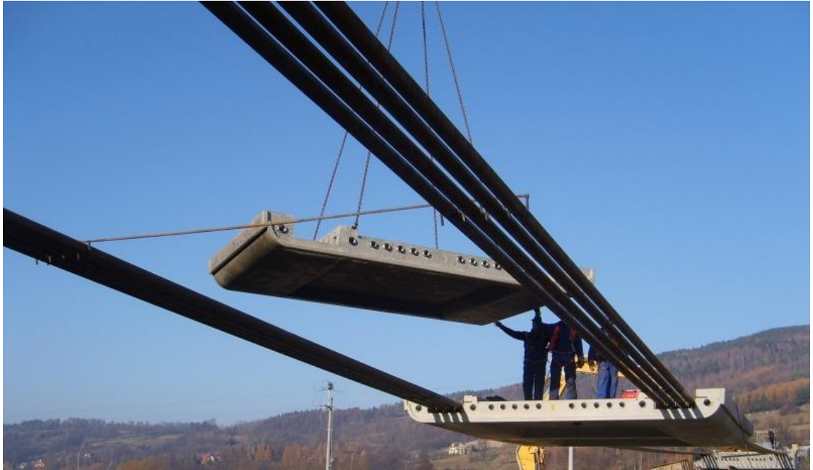
Fot.19. Montaż segmentów prefabrykowanych kładki wstęgowej w Lubiążu [33]
