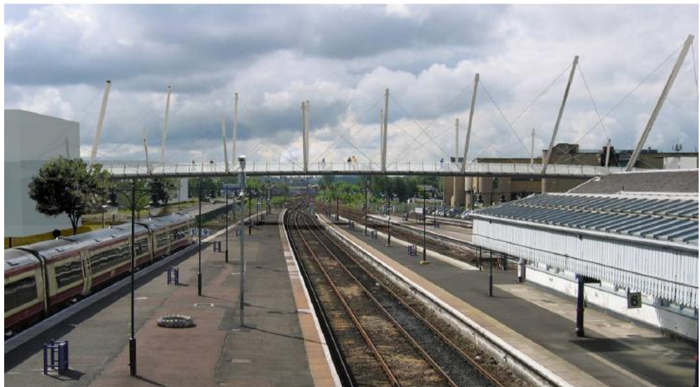
Fot.30. Kładka Forthside Bridge nad liniami kolejowymi [2]
