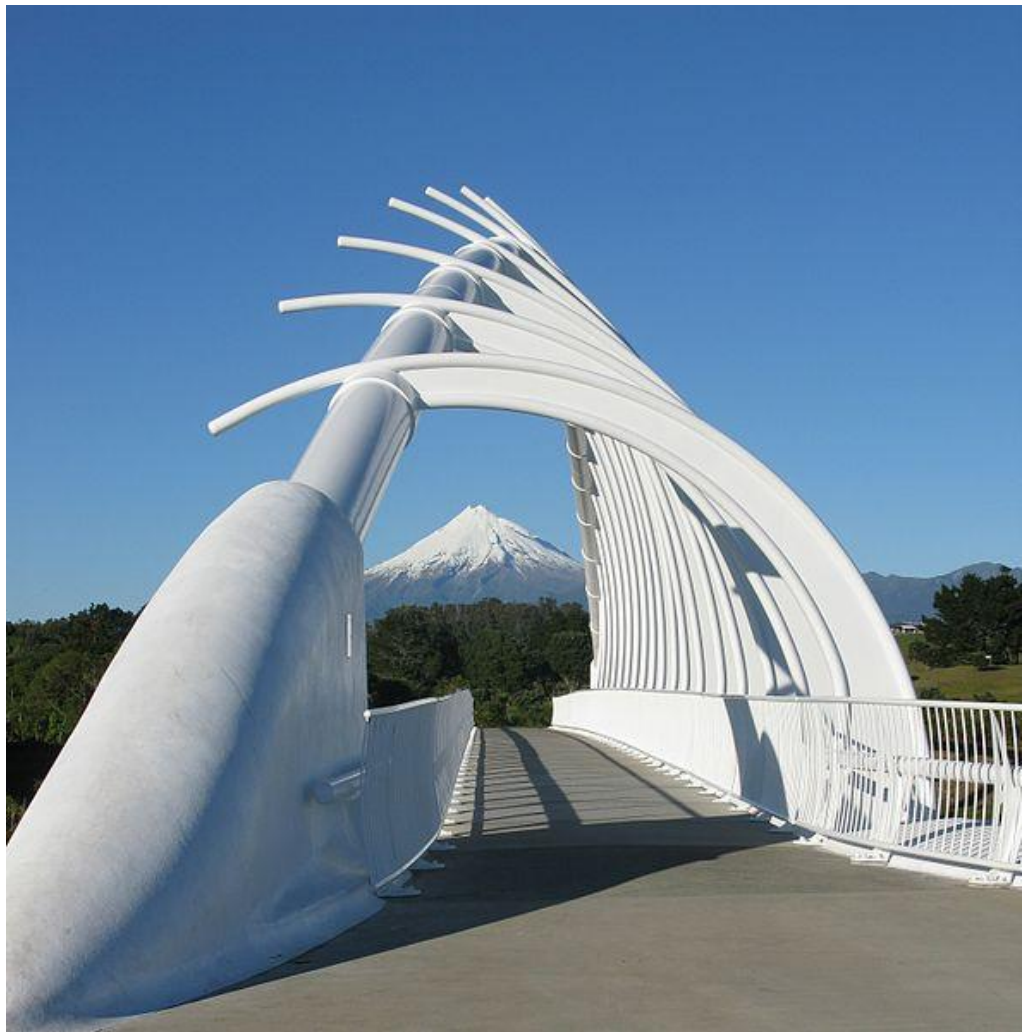
Fot.7. Te Rewa Rewa Bridge nad rzeką Waiwhakaiho w New Plymouth, Nowa Zelandia [20]
