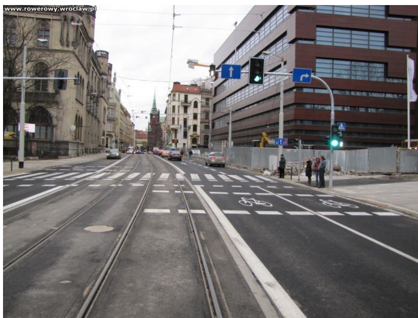
Śluzy rowerowe przed osygnalizowanym przejściem dla pieszych i przejazdem rowerowym
